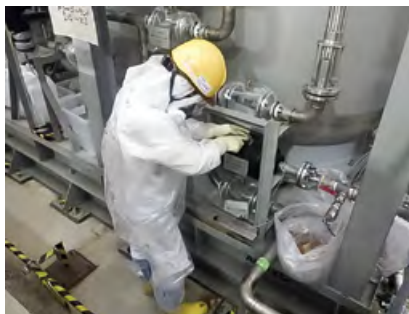
吸着材の逆洗作業
