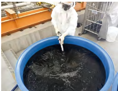
吸着材の交換作業
