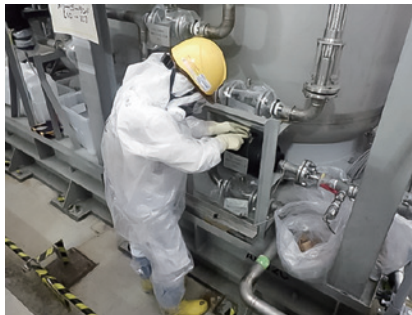
吸着材の逆洗作業
