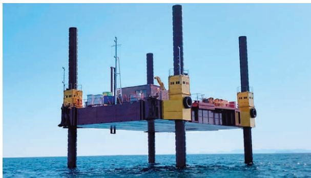
長崎県西海市江島沖において風車設置予定位置の海底地盤調査を実施
