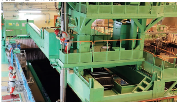
7号機の健全性確認のために燃料装荷を実施
