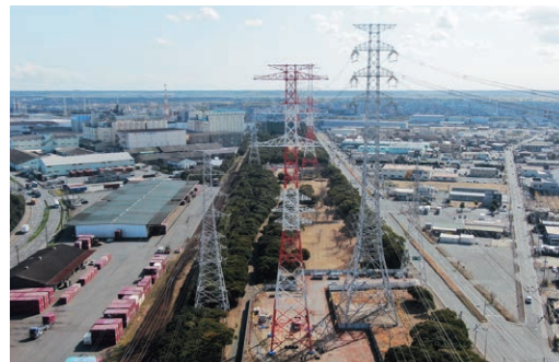
効率的かつ確実な設備保全を推進（高経年化した鉄塔の更新工事の様子）
