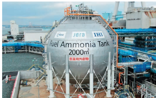
ゼロエミッション火力発電の実現に向けて燃料の20%をアンモニアに転換
