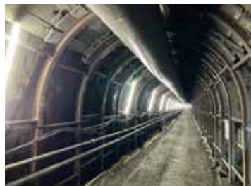
試掘坑(横坑)内部の写真
