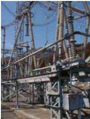
500kV 福島山幹線 1号碍子破損
