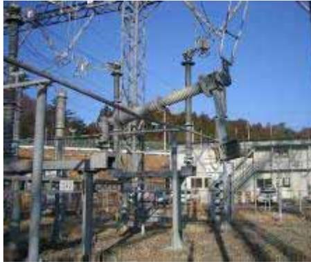
275kV いわき幹線 2 号碍子破損
