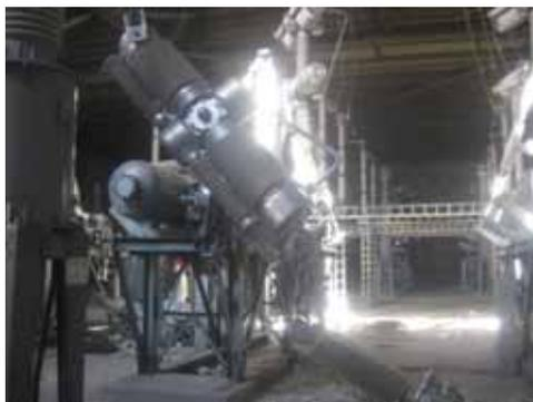
大熊線 1 L STr 回線遮断器 (O-81) 遮断部碍子全損
