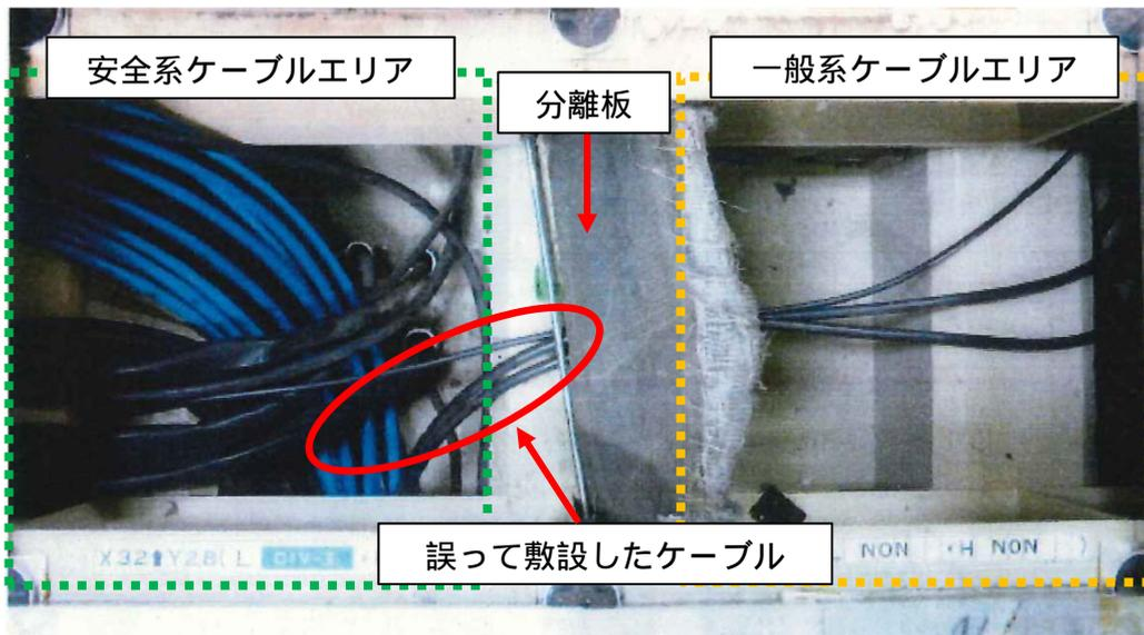
不適切な状態の例(分離板の倒れ、ケーブル混在)
