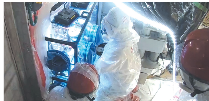
燃料デブリを運搬用ボックスに入れて取り出す様子(2025年4月23日撮影)
