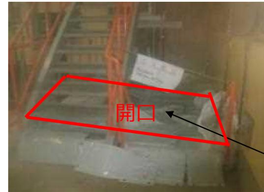
階段開口部（赤枠部）を難燃シートで養生し、隙間を発泡ウレタン等で充填
