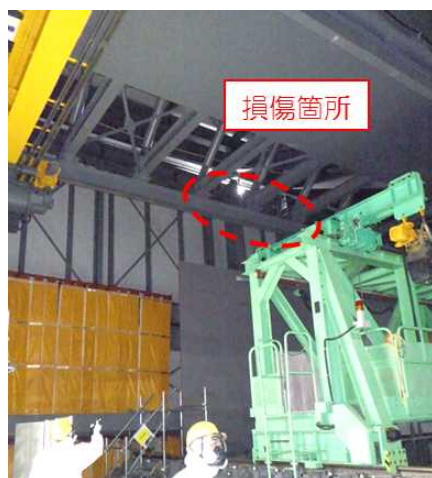
【写真①】 損傷を確認した外壁 （内側から撮影）
