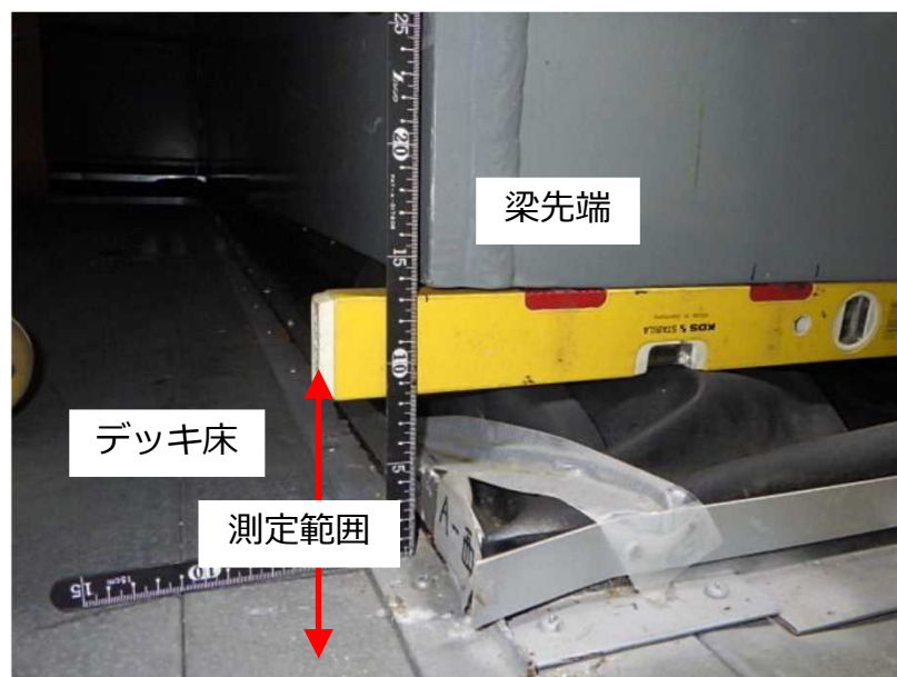
【梁先端部 計測状況】
