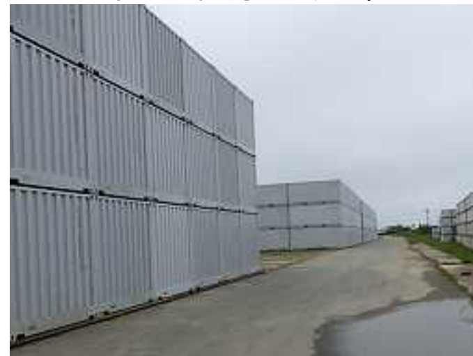
対策後の状況 (2022年6月27日完了)
