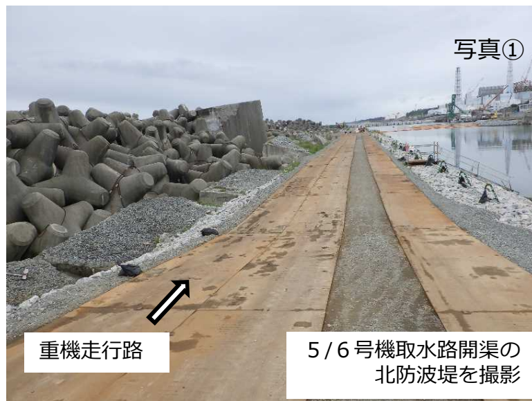
重機走行路整備の状況
