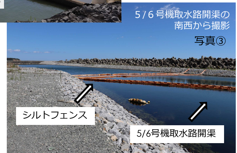
5・6号機海側工事エリアの状況
