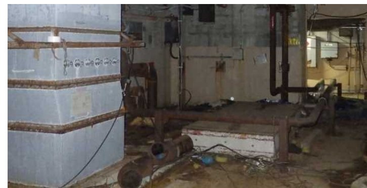
中央ハッチ付近（ROV投入箇所）
