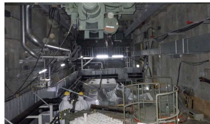
ハッチ付近（ROV投入箇所）
