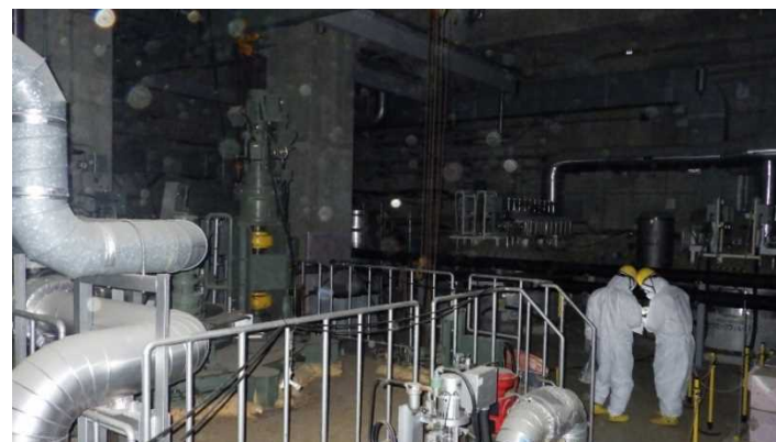
建屋西側付近（容器搬出入箇所）
