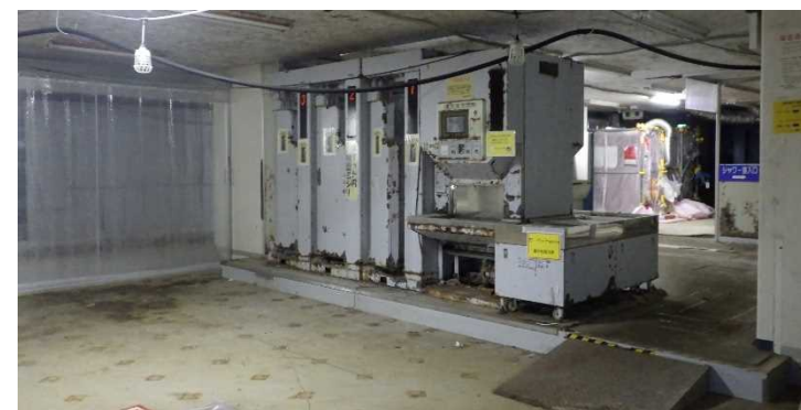
補機設置予定エリア付近
