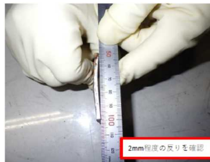
ボルト及び座金等 締結部材の状態
