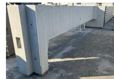
上流水槽隔壁
