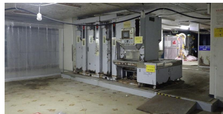
補機設置予定エリア付近
