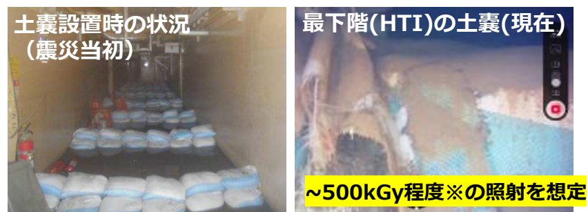
ゼオライト土嚢袋の現場状況
