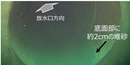
放水トンネル入口の状況
