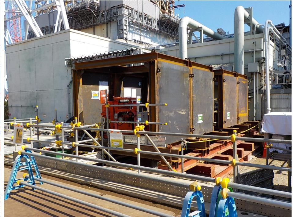
南側：削孔・注入架台設置完了
