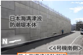
日本海溝津波防潮堤
