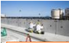
千島海溝津波防潮堤の仕上げ作業
