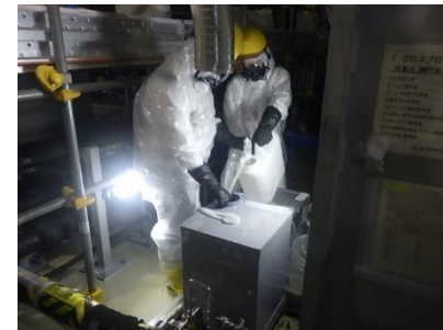
クロスフローフィルター洗浄作業
