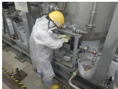
吸着材逆洗作業
