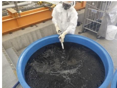
吸着材交換作業
