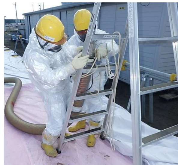
脚立へのホース端部固定作業状況
