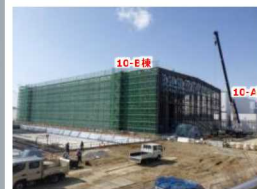
固体廃棄物貯蔵庫第10棟
