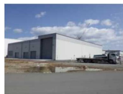
減容処理設備
