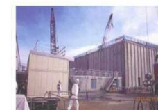
廃スラッジ一時保管施設
