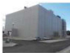
雜固体廃棄物焼却設備
