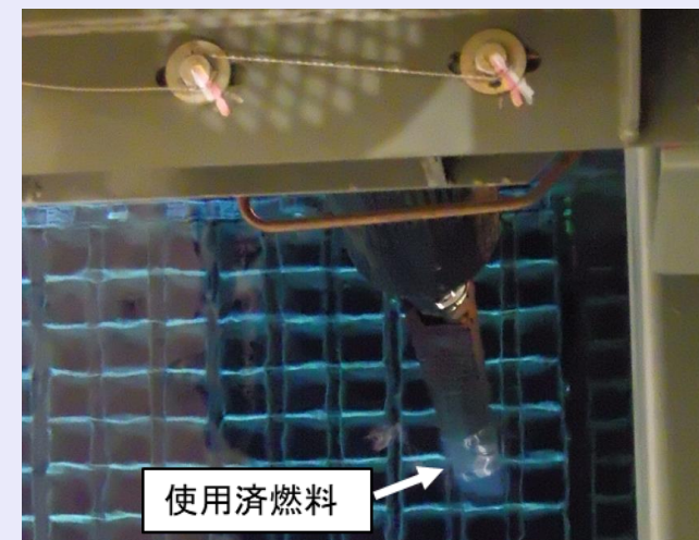
6号機での使用済燃料取り出し状況
