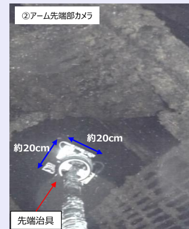
開口2上部の状況
