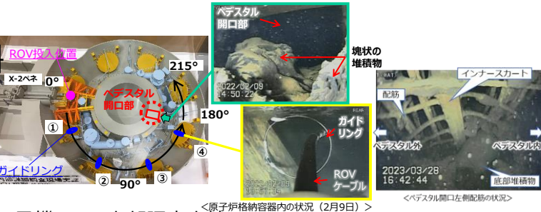
1号機 PCV内部調査実績
