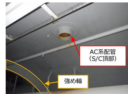
(参考) 5号機AC系配管のS/C突き出し状況
