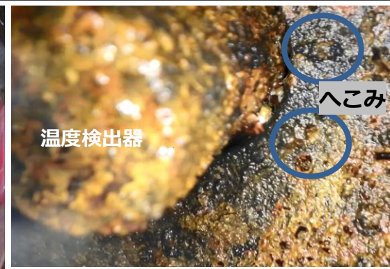
6 温度検出器(鞘管)の下流側
