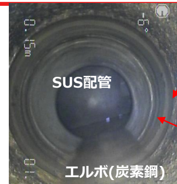
3 SUS側と炭素鋼の異材溶接部
