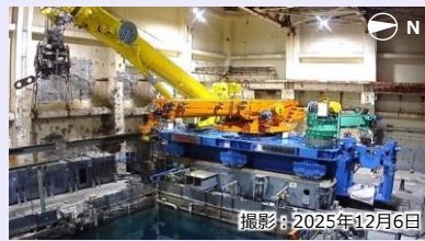
原子炉建屋内燃料取扱設備全景
