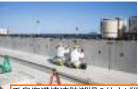
千島海溝津波防潮堤の仕上げ作業
