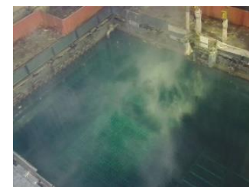
湯気発生時のSFP状況(2024年10月)
