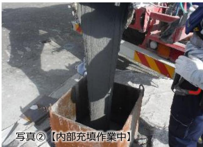
写真②【内部充填作業中】
