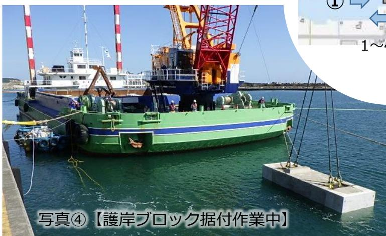
写真④【護岸ブロック据付作業中】
