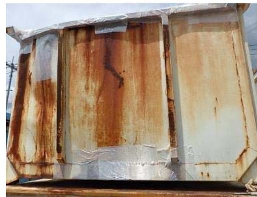
写真6.養生テープで補修後の写真5のコンテナ
