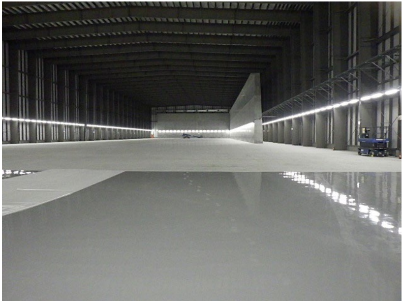
図2.固体廃棄物貯蔵庫 10-C棟の内装 (2025年4月7日撮影)
