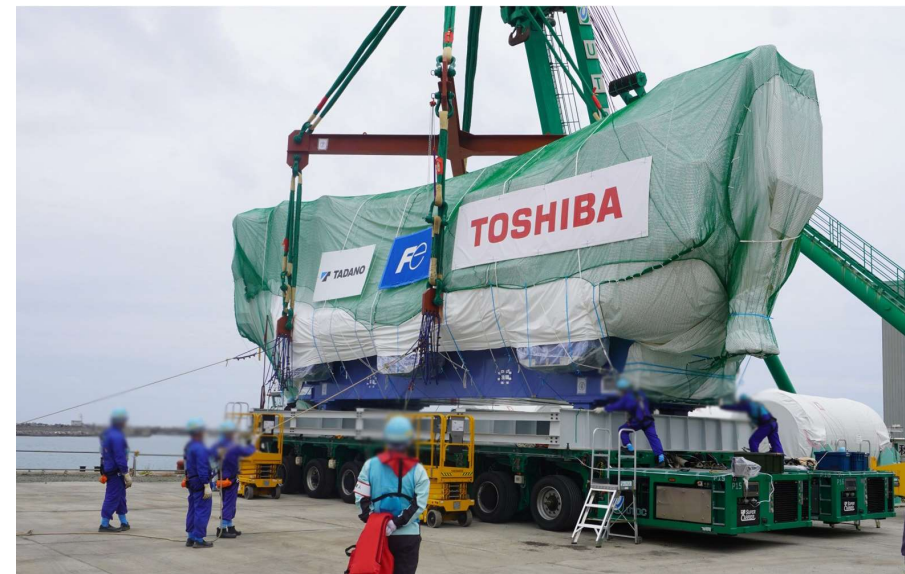
燃料取扱設備をスーパーキャリアに載せる様子 (5月24日撮影：写真の一部を加工しています)
