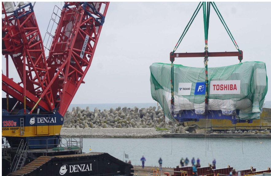
燃料取扱設備の陸揚げの様子 (5月24日撮影：写真の一部を加工しています)
