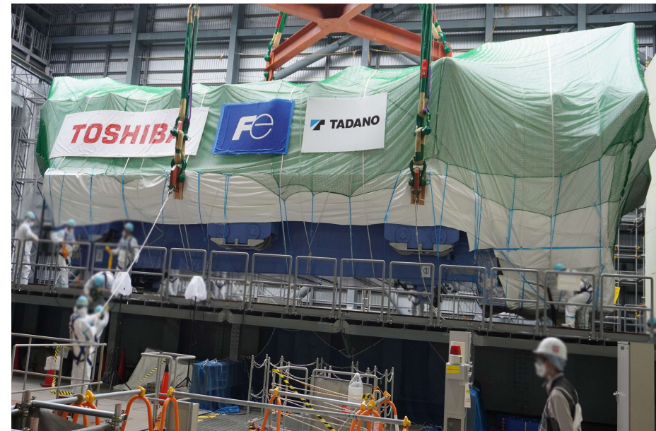
燃料取り出し用構台内でのレールへの据え付けの様子 （写真の一部を加工しています）：5月30日撮影
