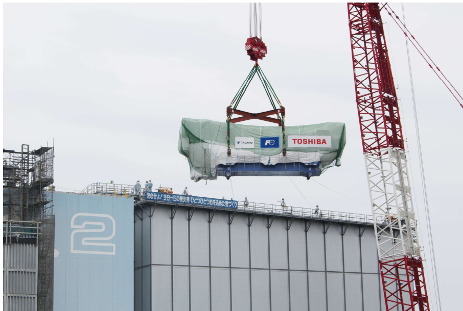
クレーンによる燃料取扱設備の引き上げの様子：5月30日撮影
