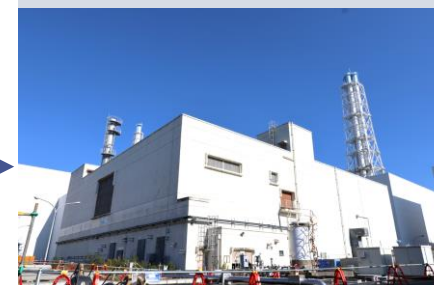
高温焼却炉建屋
