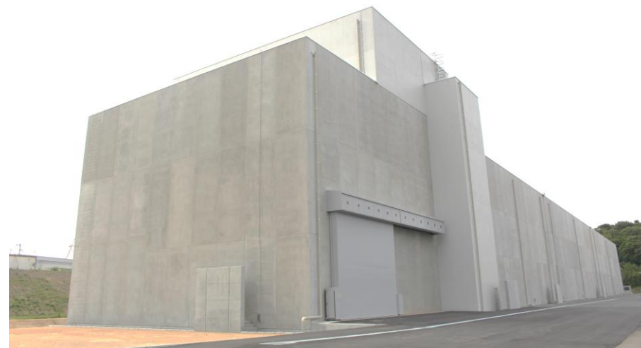
屋内保管 大型廃棄物保管庫
