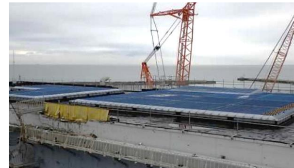
3号機タービン建屋 損傷部補修
