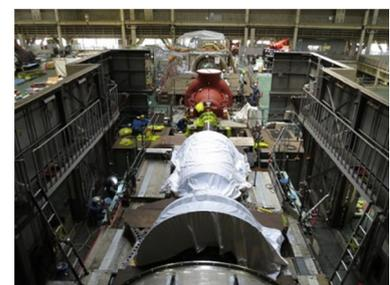
ガスタービン設備分解作業
