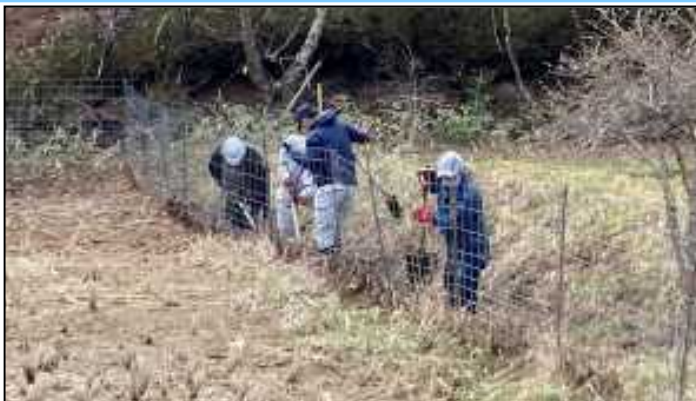
用水路整備の様子【4月16日撮影】
