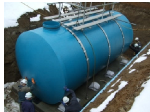
耐震防火水槽の設置の様子
