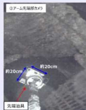
開口2上部の状況
