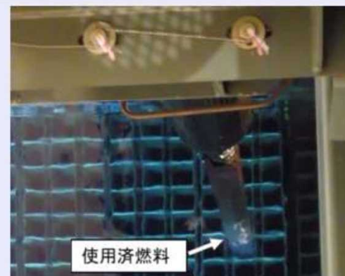
6号機での使用済燃料取り出し状況
