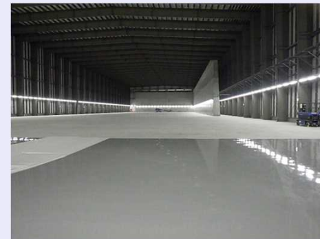
10-C棟の内部（2025年4月7日）
