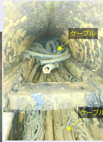
X-6ペネ内部 (PCV内より撮影)
