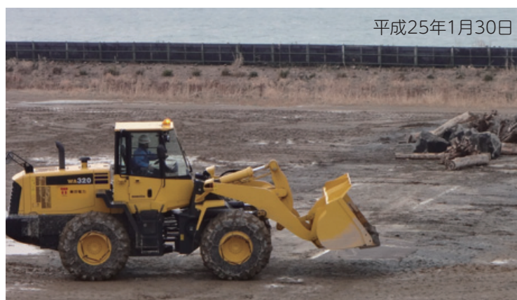
構内の専用訓練場でがれき除去訓練
