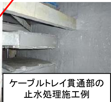
止水処理: 重要機器室への浸水防止(約300箇所)
