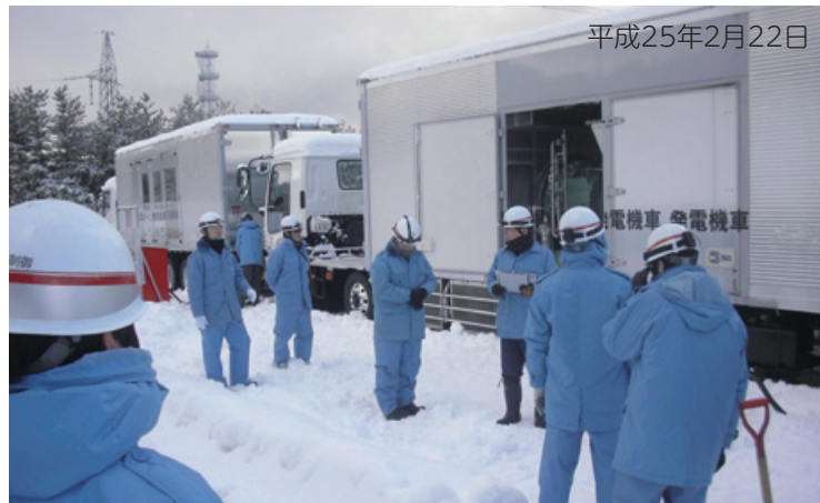
非常用のガスタービン発電機車の起動訓練
