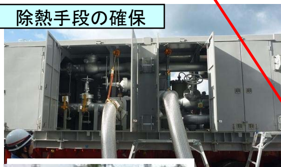
代替高圧注水設備設置
