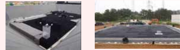
地下貯水槽設置状況
