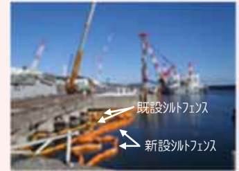
シルトフェンス交換の様子
