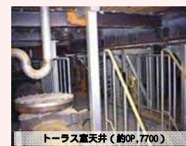
トラス室天井（約OP.7700）
