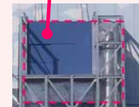
閉止パネル設置完了後
