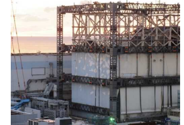
(1号機建屋カバー壁パネル取外状況)
