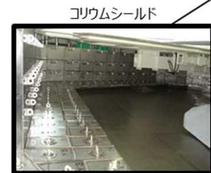
耐熱性の高い堰を設置し、溶融燃料によって、鋼製の原子炉格納容器境界板が損傷することを防止
