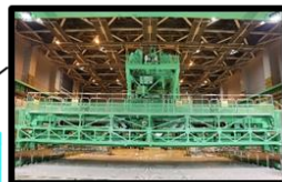
耐震強化工事を実施
