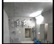
中央制御室待避室
