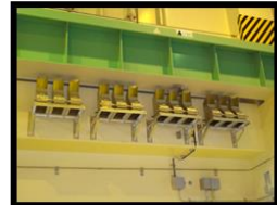
静的触媒式水素再結合装置（PAR）
