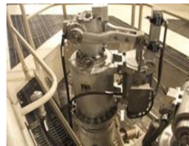
主蒸気隔離弁
