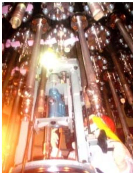
この写真は、原子炉底部の制御棒駆動装置に新規配管を取り付ける前に既設配管の取り外し作業を実施している様子です。
