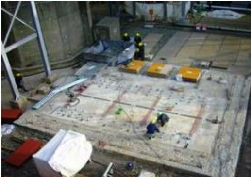
この写真は、新規変圧器を据え付ける前の基礎ボルトを設定している様子です。
