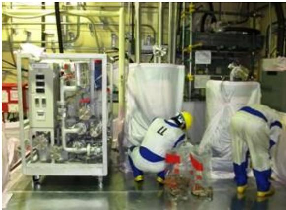
この写真は、化学除染作業が終了し、作業で使用した装置を取り外している様子です。
