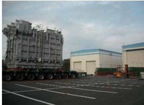
この写真は、取り外した既設変圧器を倉庫に保管する為に、搬送車から荷降ろしする準備作業をしている様
