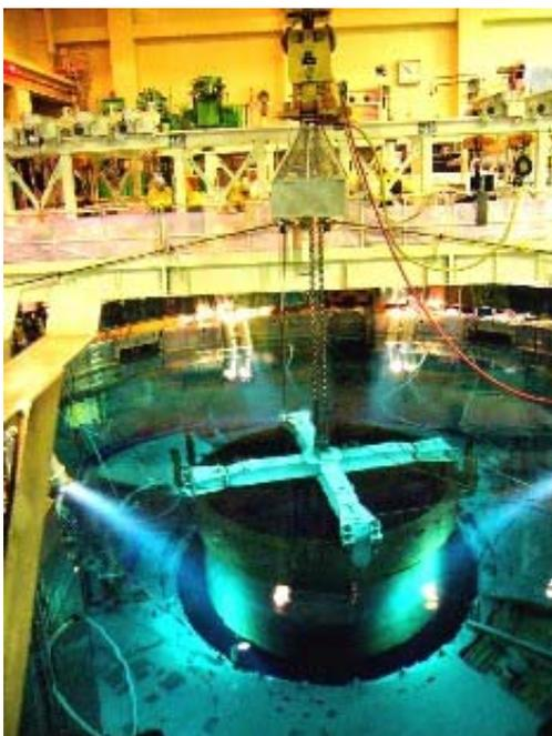
この写真は、原子炉圧力容器内から切断後の上部シュラウドを取り外している作業の様子です。
