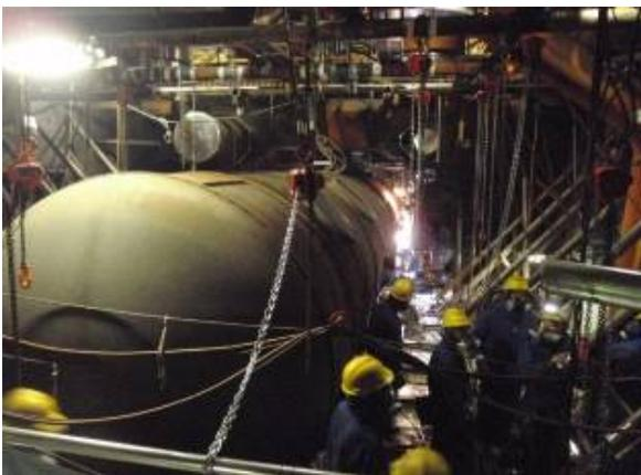
この写真は、既設給水加熱器から既設配管などを取り外している作業の様子です。
