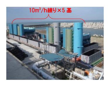
専用の製造プラント(福島第一原子力発電所構内、製造能力 50m³/h)
