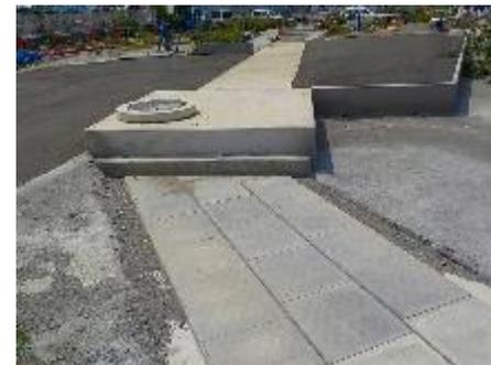
震災直後の緊急復旧のため、高圧ケーブル収納のエフレックスを地這いさせている箇所がある。
