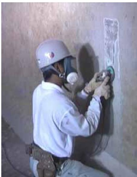
防汚塗装の塗膜(表層:シリコン系, 下地:エポキシ系)をディスクサンダーを用いて除去
