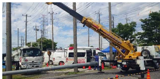
▲倒壊した電柱の除去訓練
