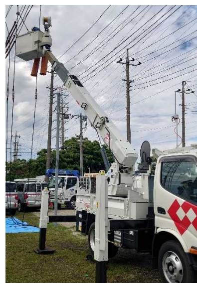
▲電力復旧訓練
