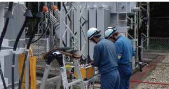
ケーブル劣化診断（直流漏れ電流診断）
